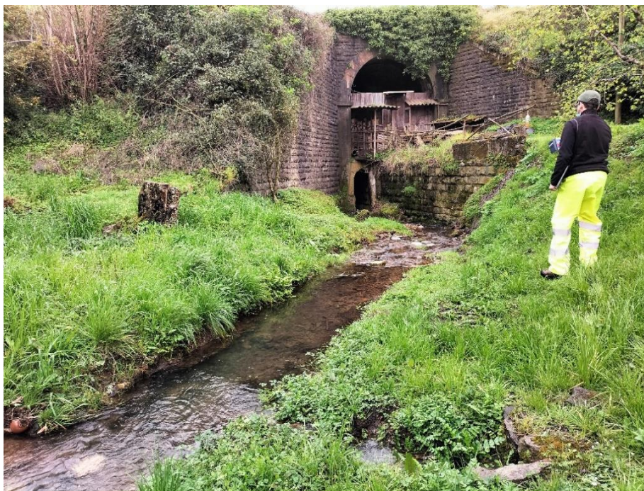
Foto 1. (862-3-17) Alteración del cauce. Cobertura del Arroyo Reguerón en su tramo final mediante Galería hasta su confluencia en el Aboño. Soterrado bajo infraestructuras de comunicación. Ausencia de vegetación de ribera. Coordenadas ETRS 89, Huso 30T, X: 277533, Y: 4821687.
