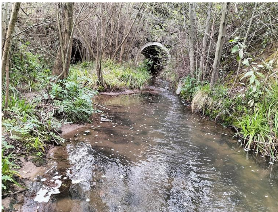
Foto 2. (862-1-18) Alteración de cauces. Entubamiento de los arroyos Vegona y Melendrera hasta su confluencia, continuando el Melendrera encauzado hasta su confluencia con el Aboño. Coordenadas ETRS 89, Huso 30T, X: 277561, Y: 4821666.
